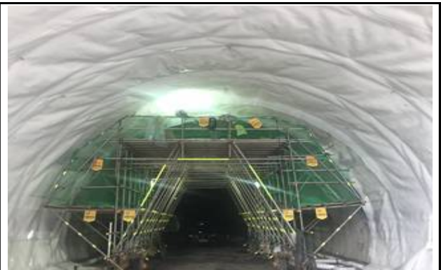
방수쉬트 작업 가시설 현황
