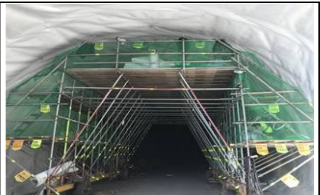
방수쉬트 작업 가시설 현황
