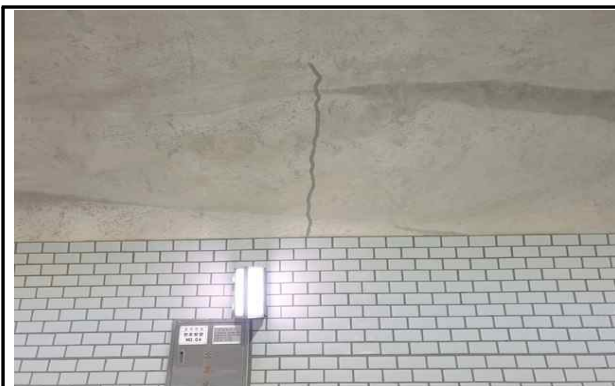
균열 보수 전경
