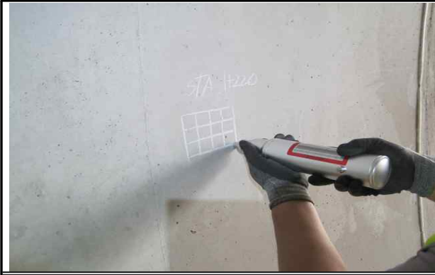
라이닝 콘크리트 강도 측정
