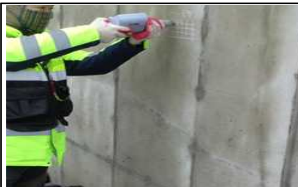
콘크리트 강도조사(반발경도시험) 전경
