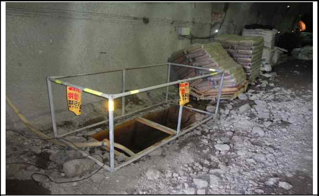
오·폐수 처리시설 전경
