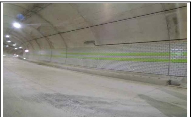
측벽부 타일 전경
