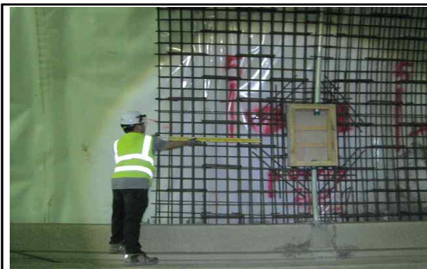
철근 배근 현황
