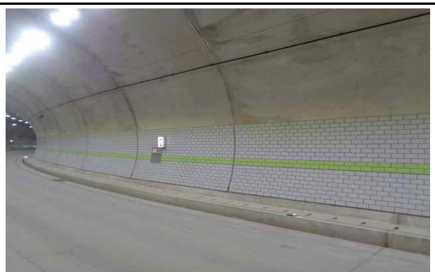
측벽부 타일 전경
