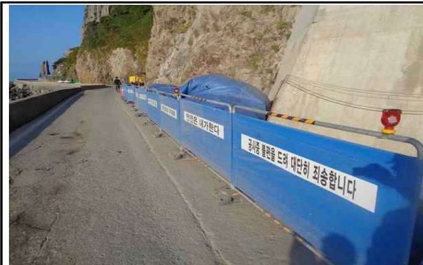
도로 안전 펜스 전경
