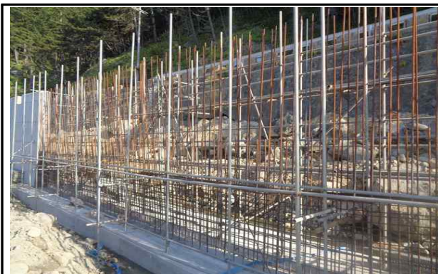
옹벽 전면 강관 비계 설치 현황
