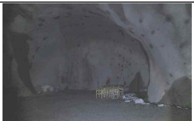
STA 2+960(방향전환소) 현황
