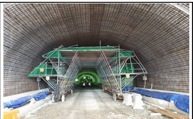
철근 작업 가시설 현황
