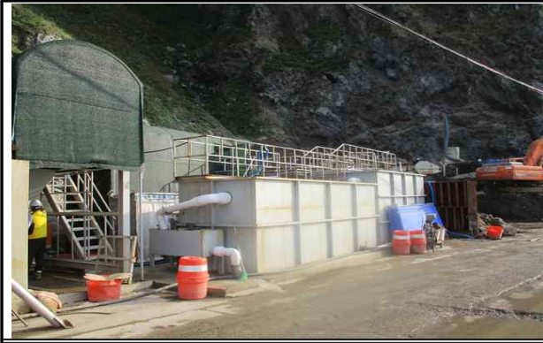
오·폐수 처리시설 전경
