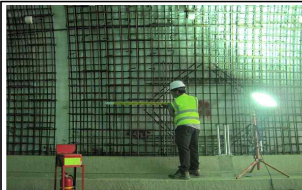
철근 배근 현황
