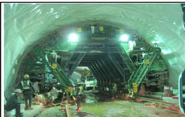
라이닝 콘크리트 타설 가시설 현황
