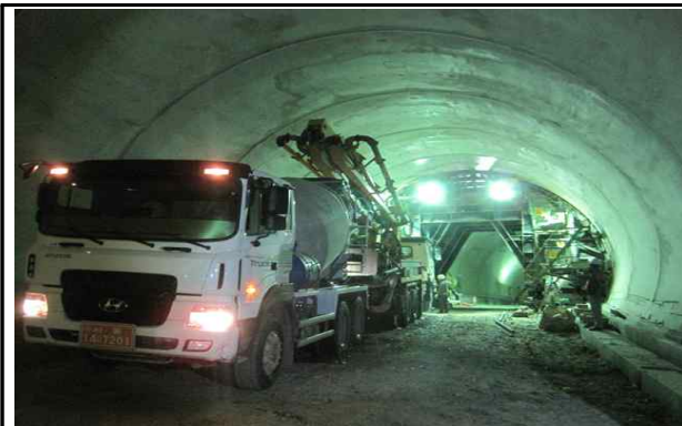
라이닝 콘크리트 타설 가시설 현황
