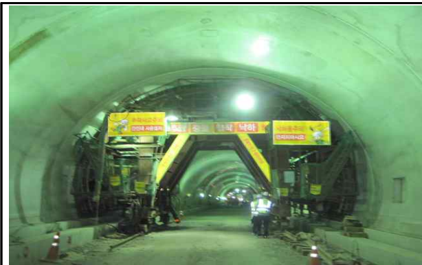
라이닝 콘크리트 타설 가시설 현황
