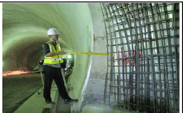
라이닝 콘크리트 현황
