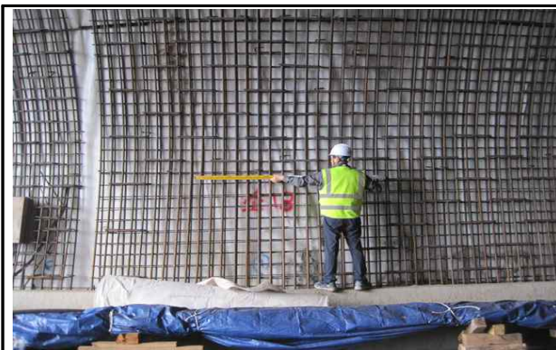
철근 배근 현황
