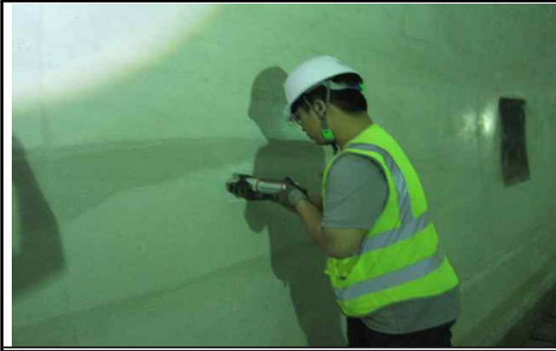
라이닝 콘크리트 강도 측정
