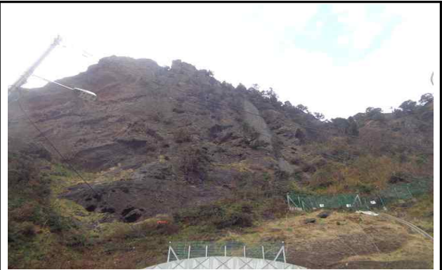
종점측 터널부사면 전경
