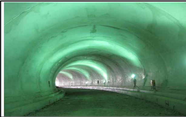
라이닝 콘크리트 현황
