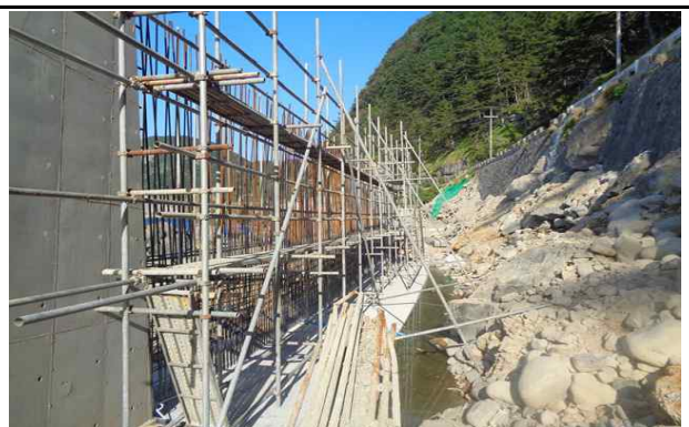
옹벽 배면 강관 비계 설치 현황
