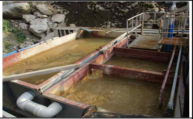
오·폐수 처리시설 전경
