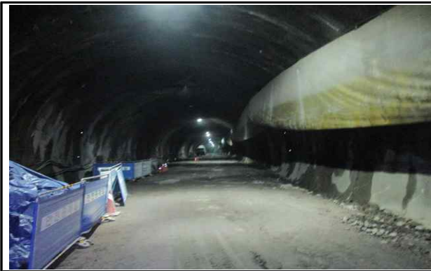
안전펜스 및 자재정리 현황
