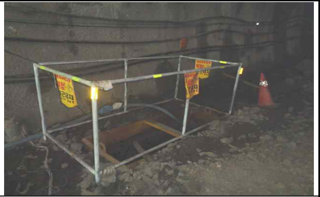
오·폐수 처리시설 전경
