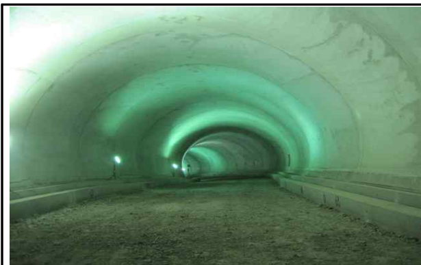
라이닝 콘크리트 현황
