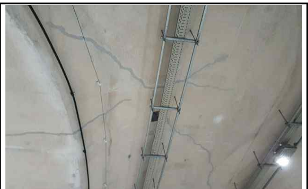
균열 보수 전경
